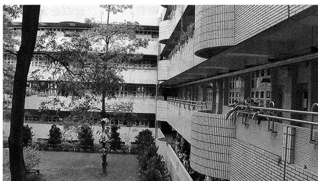
図3 桂林国民小学校舎
