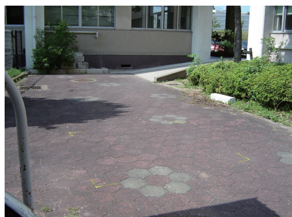
写真39 第3調査区調査前全景（南から）
