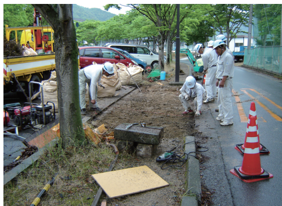
写真 16 掘削の様様（北西から）
