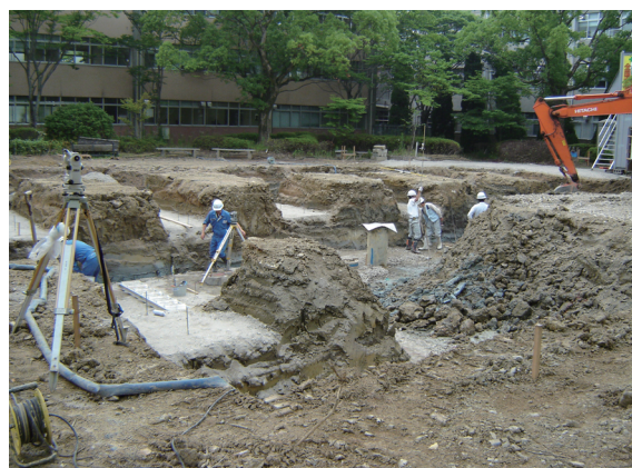
写真17 基礎工事掘削の様相（東から）
