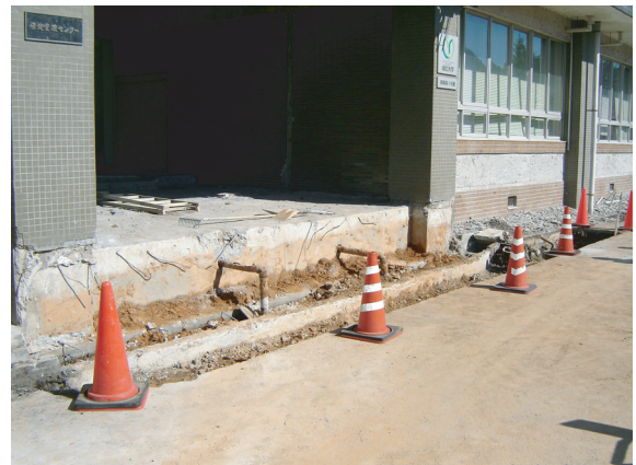
写真20 調査区全景（南西から）
