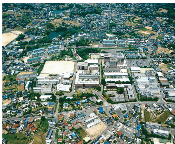
写真5 常盤構内航空写真（南から）
