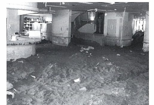
写真-3 老人ホーム内部の土砂堆積
