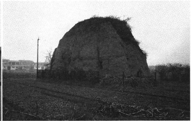
写真14 未央宮版築基壇（南西から・橋本撮影）
