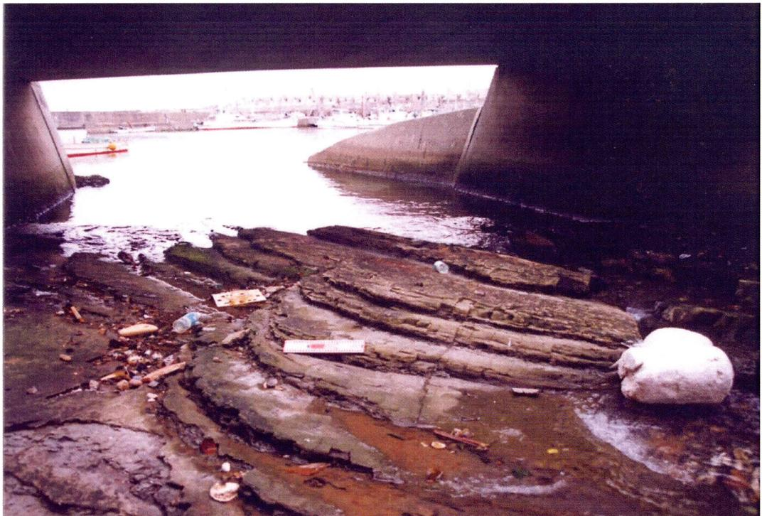
写真-4.19 流れ盤 (N81° E, 18° N) をなす頁岩層（東立石～青村地区）
