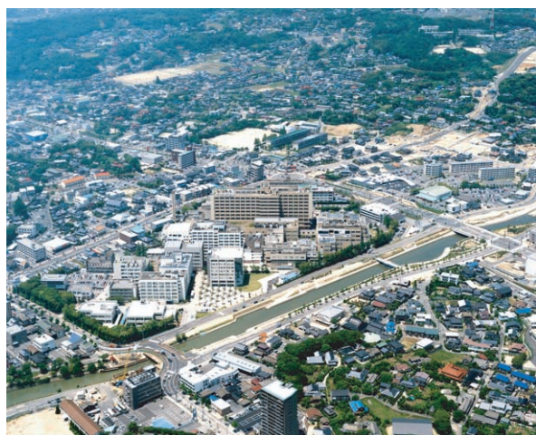
写真4 小串構内航空写真（南東から）
