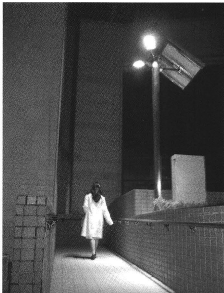
図3 省エネルギー型太陽電池式白色LED街灯
