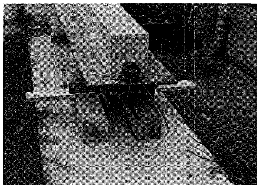
写真-6 緊張作業を終了した時の定着金具の状況
