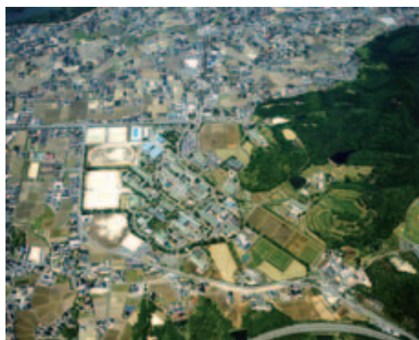
写真1 吉田構内航空写真(南東から)
