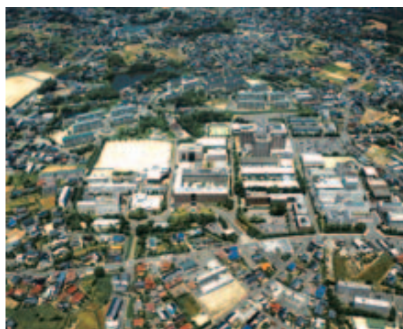
写真5 常盤構内航空写真(南から)
