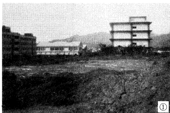
〈現第2食堂敷地の調査(昭和46年11月)〉 全景
