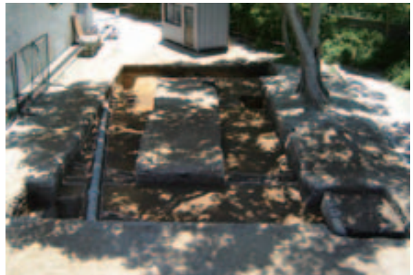
写真 59 調査区全景 (北東から)
