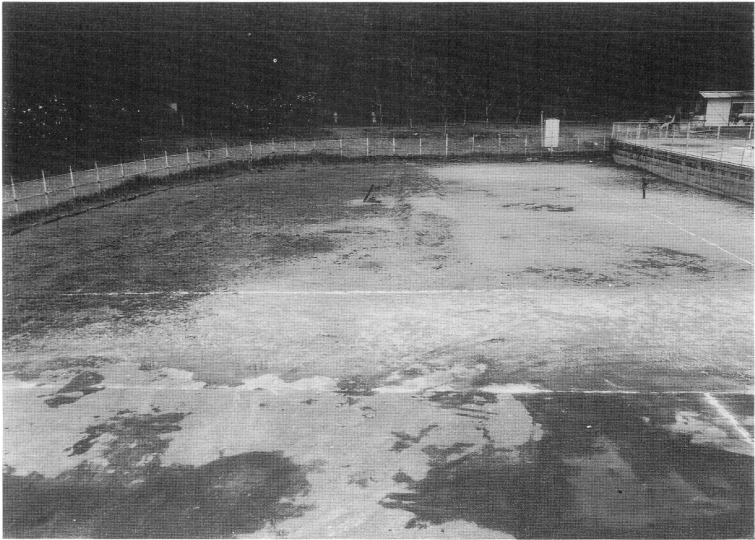
(1) 調査前全景（北から）
