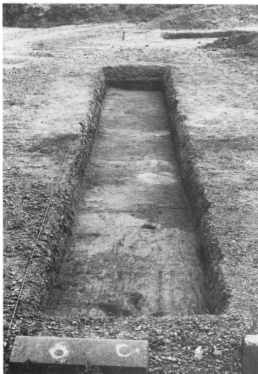
(3) Cトレンチ河川跡検出状況(西から)
