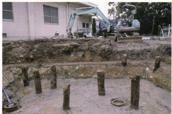
写真 8 調査区北壁土層断面 (南から)
