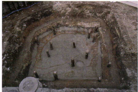
写真 6 調査区全景 (東から)
