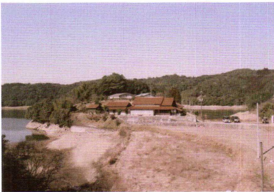
写真 42 ボート部合宿所全景 (南から)
